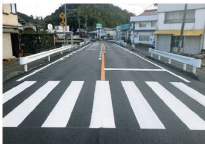
平和通舗装補修工事
