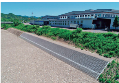
武儀川護岸(千疋)工事
