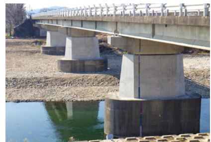
千疋橋耐震補強工事
